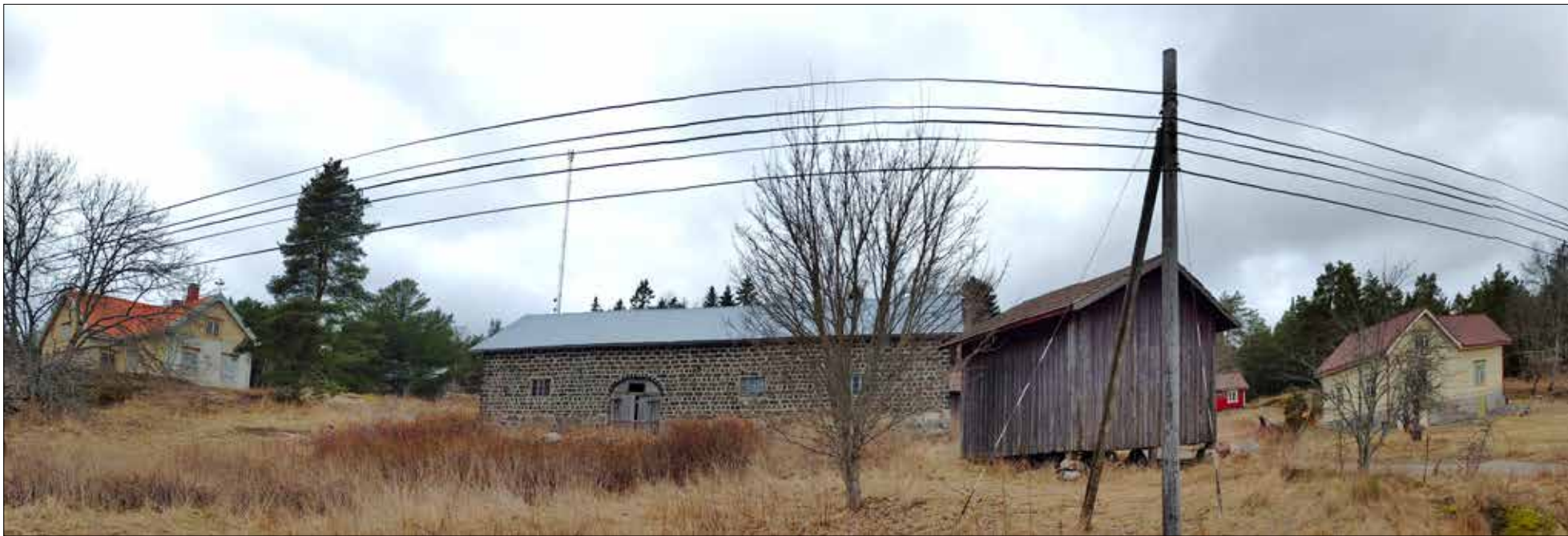
Bostadshuset Klemmis och Maggis på Vestergård, ladugården och andra gårdsbyggnader har rensats fram ur buskagen. De nya ägarna är glada över att husen, som stått tomma i årtionden, har bevarats i renoverbart skick. Många Västanfjärdabor har också överraskats av det öppnare kullandskapet längs Sundviksvägen. / Vestergården asuinrakennukset Klemmis ja Maggis, navetta ja muutakin piharakennuksia on perattu esiin pusikoitten peitosta. Uudet omistajat ovat ilahuneet siitä, että vuosikymmenen tyhjiillään seisoneet talot ovat säilyneet kunnostuskelpoisina. Moni västanfjärdiläinenkin on yllätynyt Sundvikenintien varrelle avartuneesta mäkimaisemasta.
