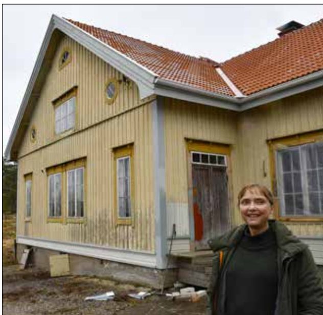
Den ståtliga huvudbyggnaden på Vestergård, kallad Klemmis, behöver fortfarande mycket renovering. Även den slutliga fasadfärgen är ännu inte bestämd. / Ryhdikkäänä pysynyt Vestergårdin päärakennus, jota Klemmikseksi kutsutaan, kaipa vielä paljon kunnostuksia. Lopullinen ulkivärkin on vielä hakusessa.
