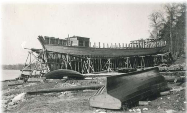
Fortuna byggs./Fortunaa rakennetaan. Bild/Kuva: Sagalund.fi
